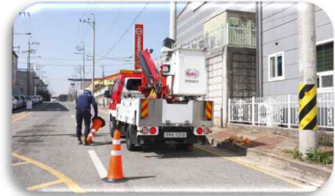
3. 작업현장 안전시설물 설치
